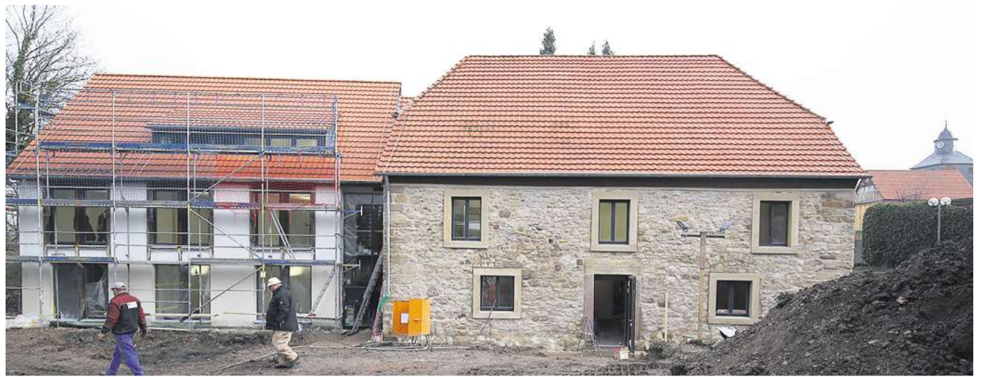
Anbau: 24 neue Büroarbeitsplätze für die Personalverwaltung des Unternehmens Tedox.
